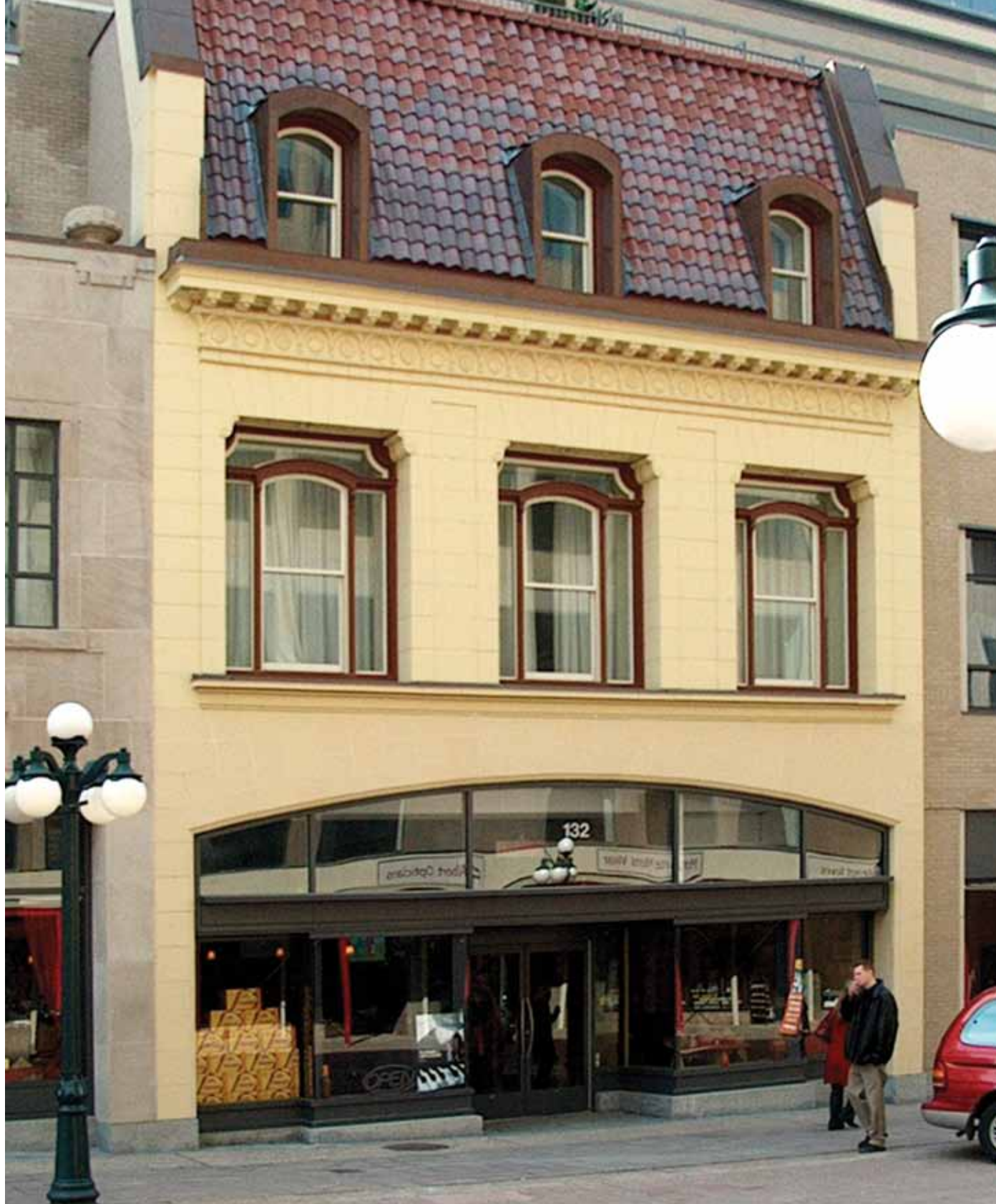
La façade en terracotta vitrifiée de l'ancien immeuble Bowles Lunch à Ottawa.
